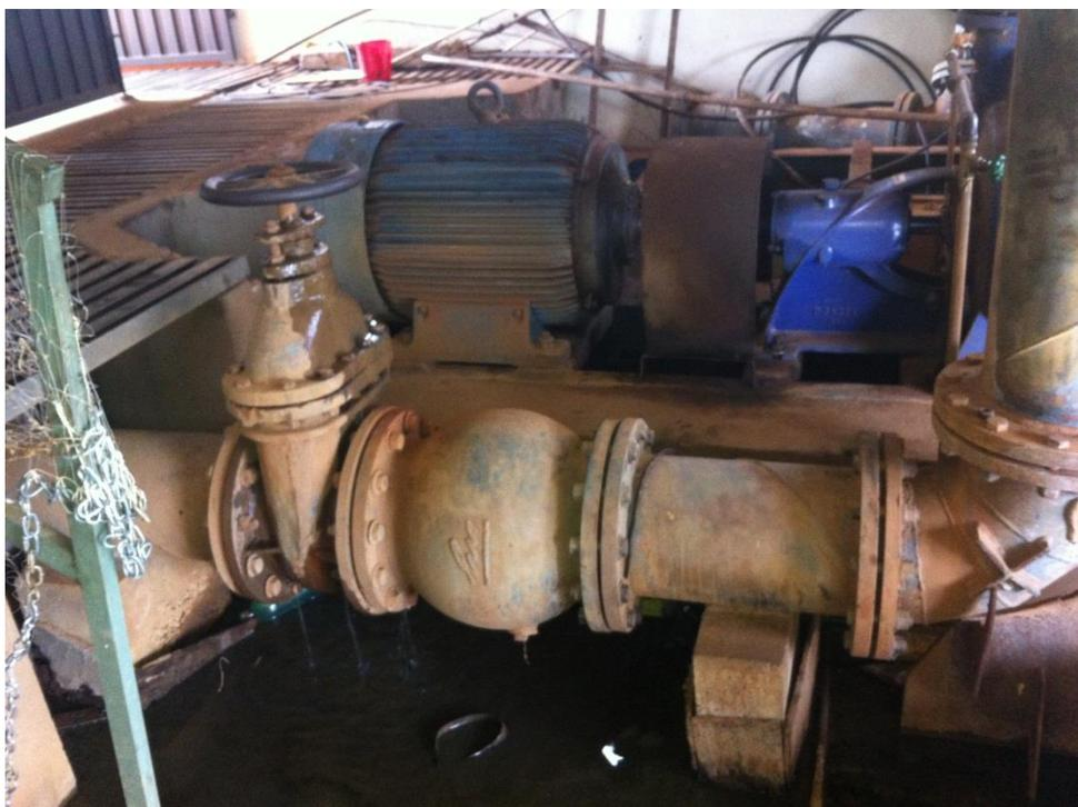
**Foto 46:** – Registros, Motor e Bomba da Captação da Água Bruta
