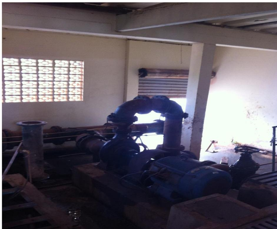
**Foto 45:** – Motor e Bomba da Captação da Água Bruta
