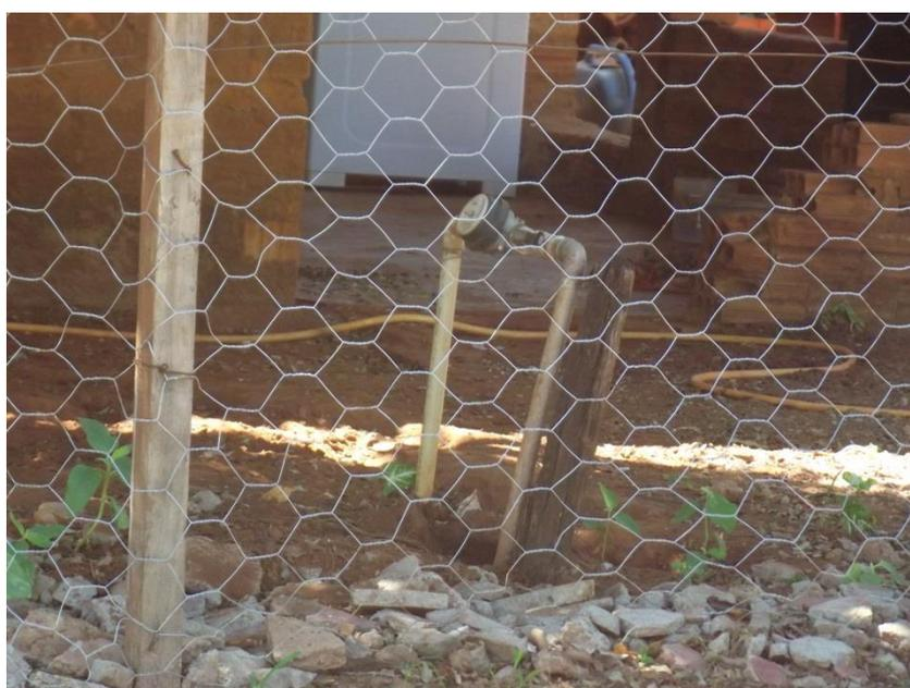
**Foto 140:** – Hidrômetro e Cavalete
