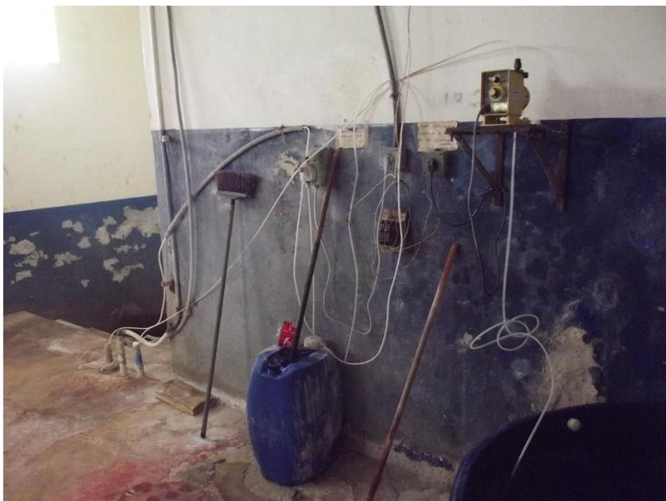
**Foto 71:** – Bombas Dosadoras para Aplicação do Ácido Fluorsilícico e Orto-Polifosfato (Econox)
