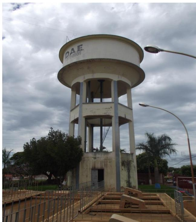
**Foto 16:** – Reservatório Elevado - ETA – Capacidade de 200m<sup>3</sup>
