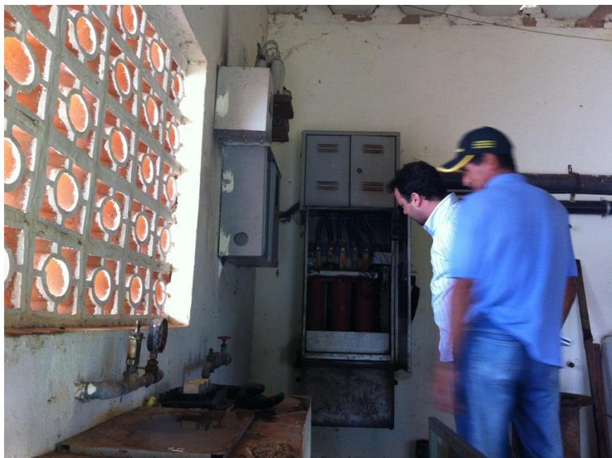
**Foto 47:** – Painel Elétrico dos Motores da Captação da Água Bruta
