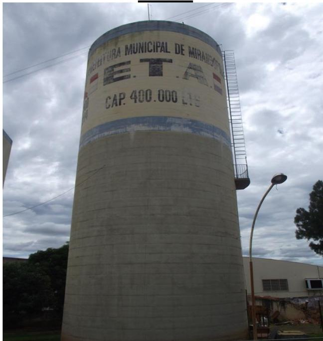
**Foto 15:** – Reservatório Elevado - ETA – Capacidade de 400m<sup>3</sup>
