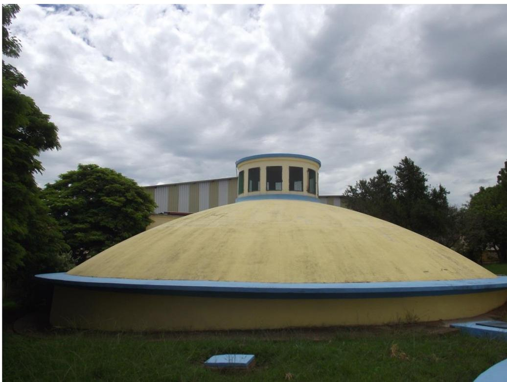
**Foto 19:** – Reservatório Semi – Enterrado II – ETA – Capacidade de 800m<sup>3</sup>
