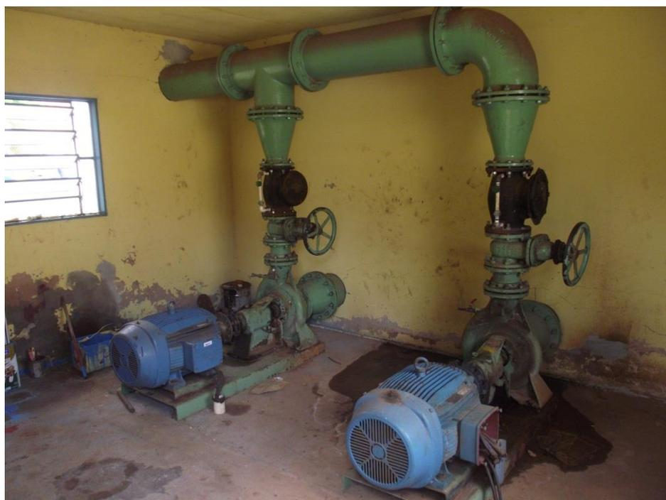
**Foto 60:** – Motores que Fazem o Recalque da Água Tratada para os Reservatórios Elevados
