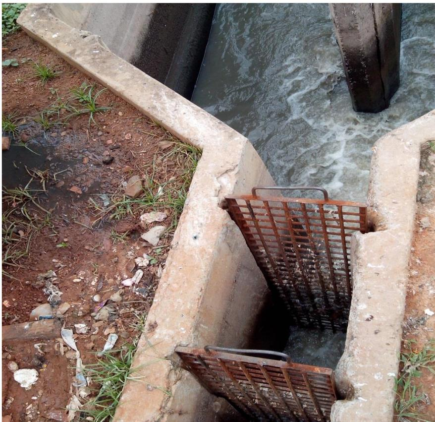
**Foto 173:** – Calha Parshall - Gradeamento
