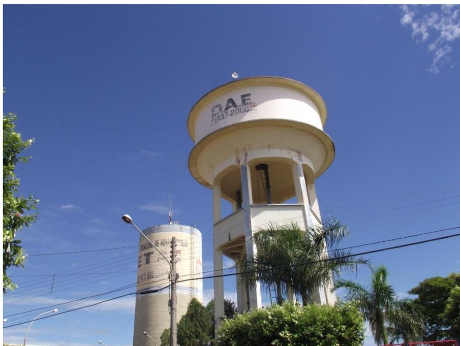
**Foto 17:** – Reservatórios Elevados – ETA – Juntos Capacidade de 600m<sup>3</sup>
