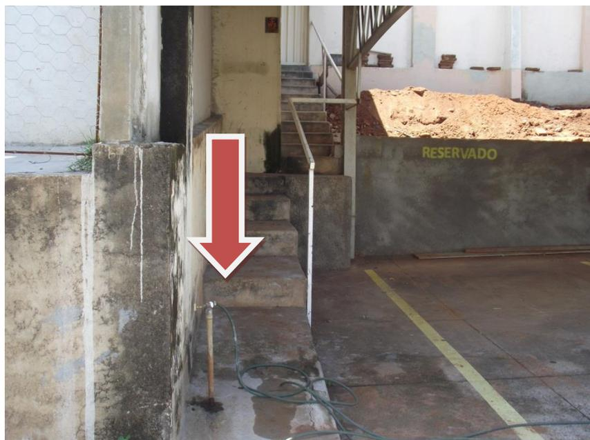
**Foto 13:** - Fotos Cavalete Sem Hidrômetro
