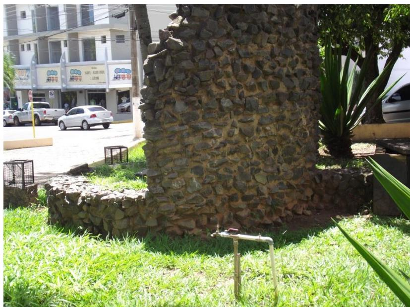
**Foto 12:** – Fotos Cavalete Sem Hidrômetro
