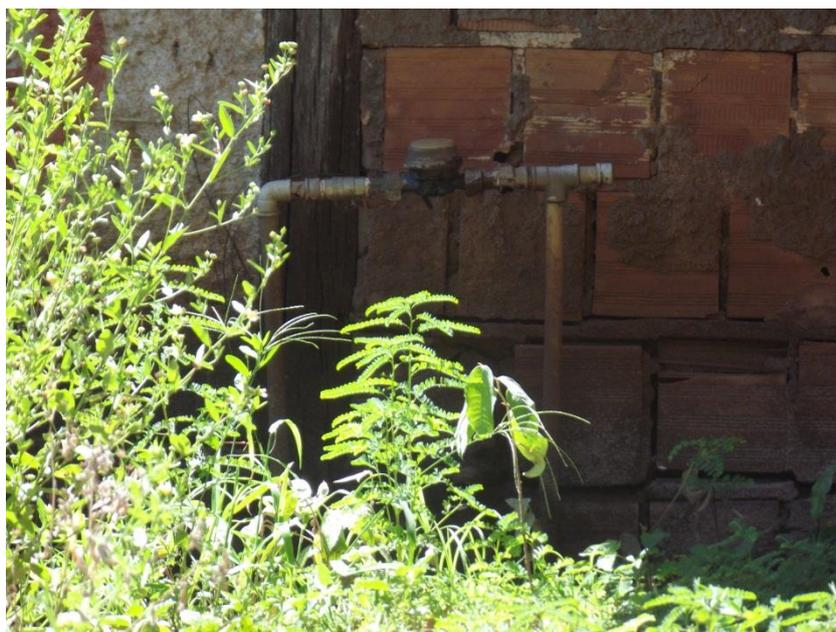
**Foto 139:** – Hidrômetro e Cavalete
