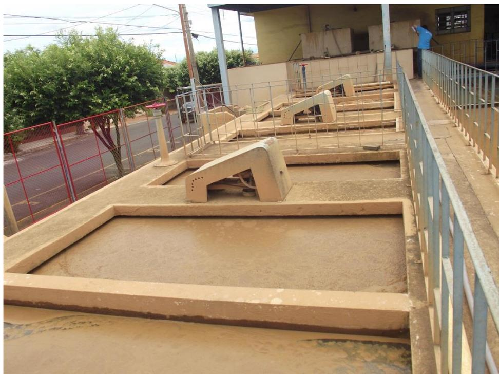
**Foto 64:** – Local onde é Feito a Flocculação da Água Bruta e Batedouros
