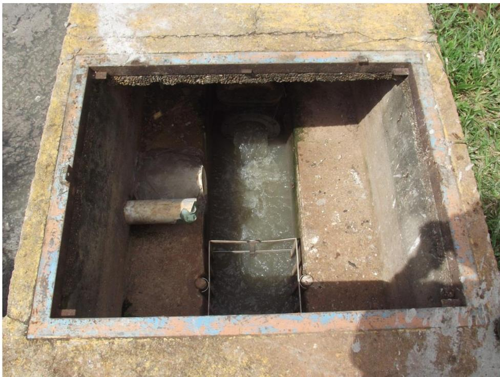
**Foto 183:** – Local da Bomba de Recalque (Bomba Submersa)
