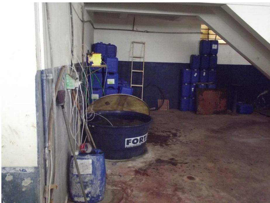
**Foto 70:** – Local onde é Feito a Aplicação do Ácido Fluorsilícico e Orto-Polifosfato (Econox)
