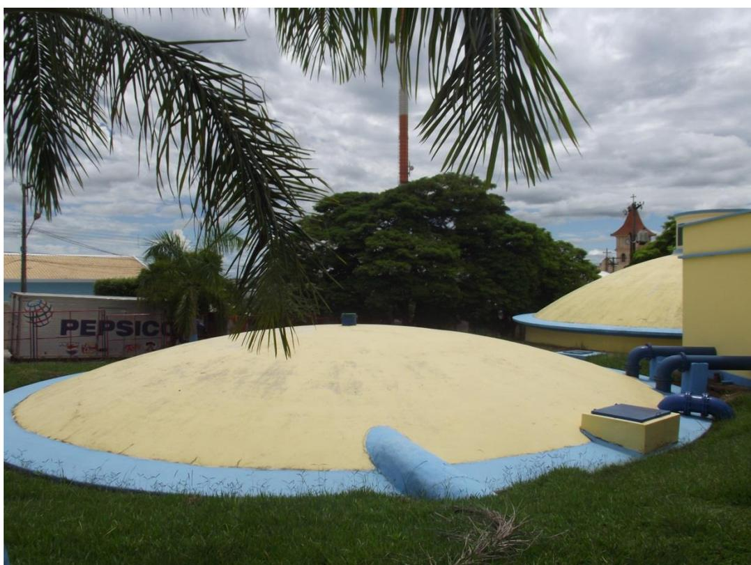
**Foto 18:** – Reservatório Semi – Enterrado I – ETA – Capacidade de 1.000m<sup>3</sup>
