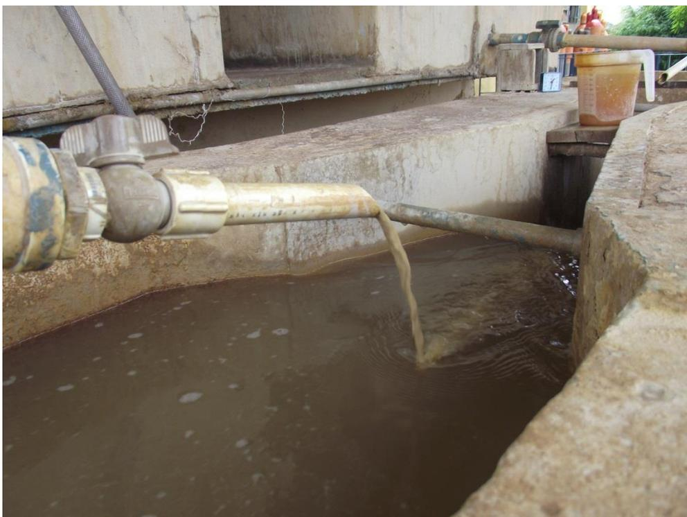
**Foto 62:** – Adição de *Sulfato de Alumínio Ferroso* – Água Bruta
