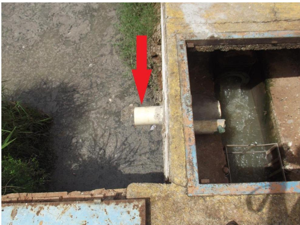
**Foto 184:** – Bomba de Recalque e Caixa de Entrada de Esgoto - Ao Lado (Seta Vermelha) onde foi feito uma saída para Extravasos
