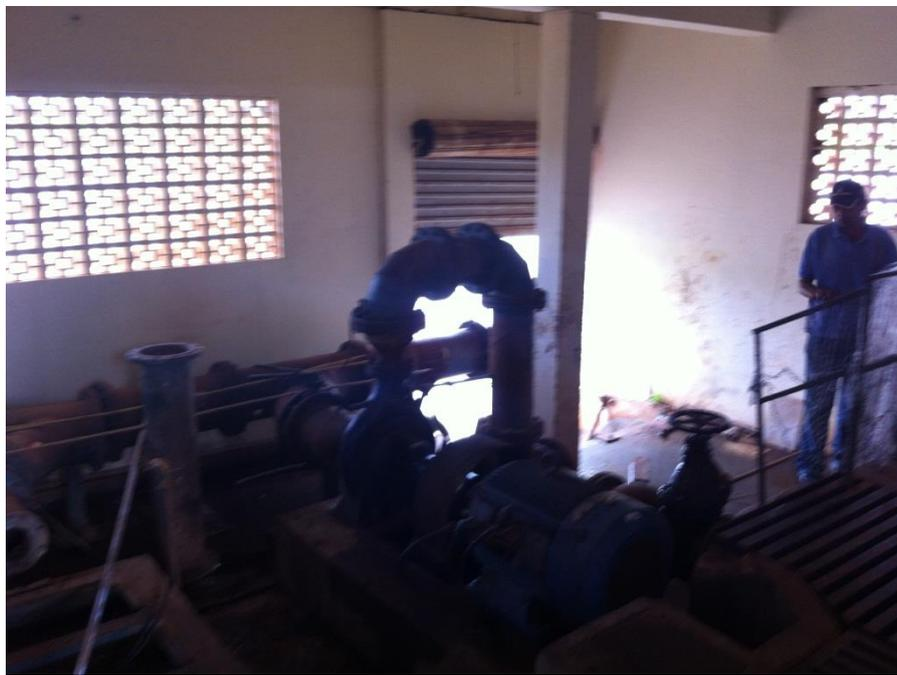
**Foto 44:** – Motor e Bomba da Captação da Água Bruta
