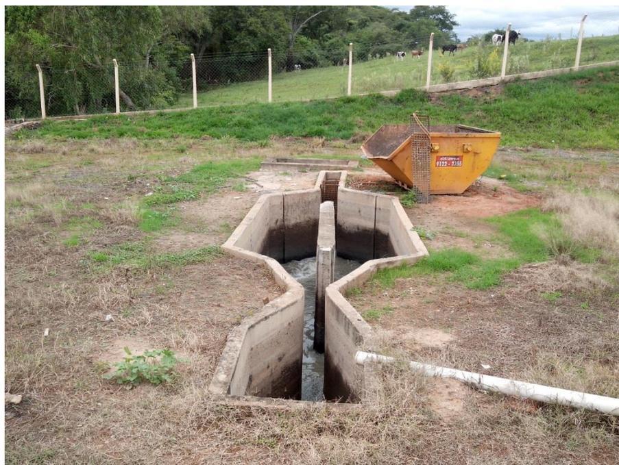
**Foto 172:** – Calha Parshall - Gradeamento
