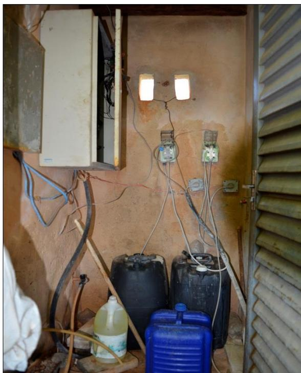
**Foto 89:** – Painel Elétrico, Bombas Dosadoras e Produtos Químicos – **Poço P3**
