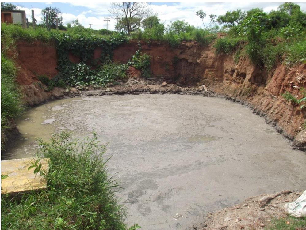
**Foto 185:** – Vala Executada pelo SAAEM para Conter os Constantes Extravasos de Esgotos
