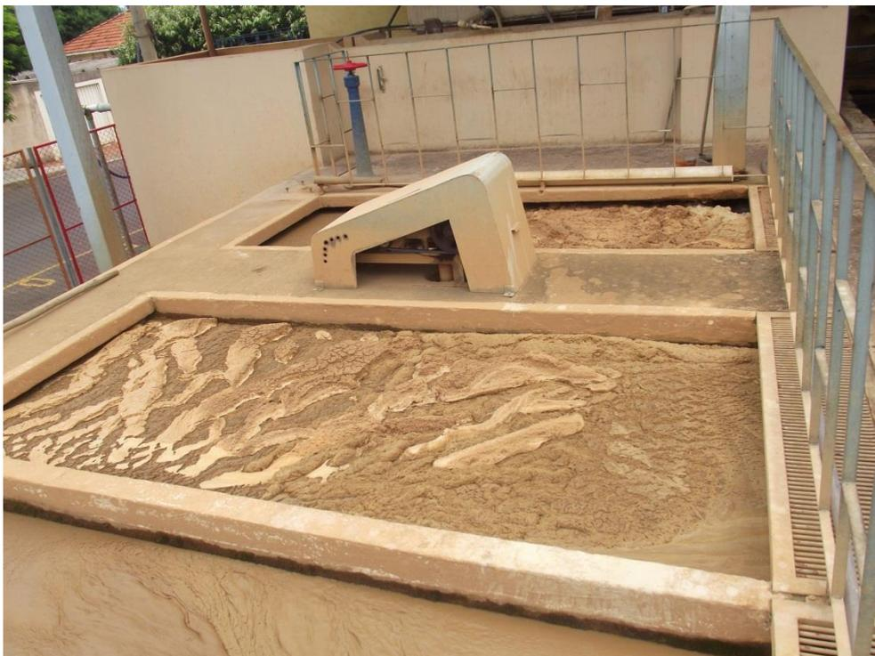
**Foto 63:** – Local onde é Feito a Flocculação da Água Bruta e Batedouros
