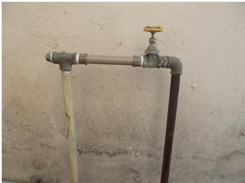
**Foto 11:** – Fotos Cavalete Sem Hidrômetro
