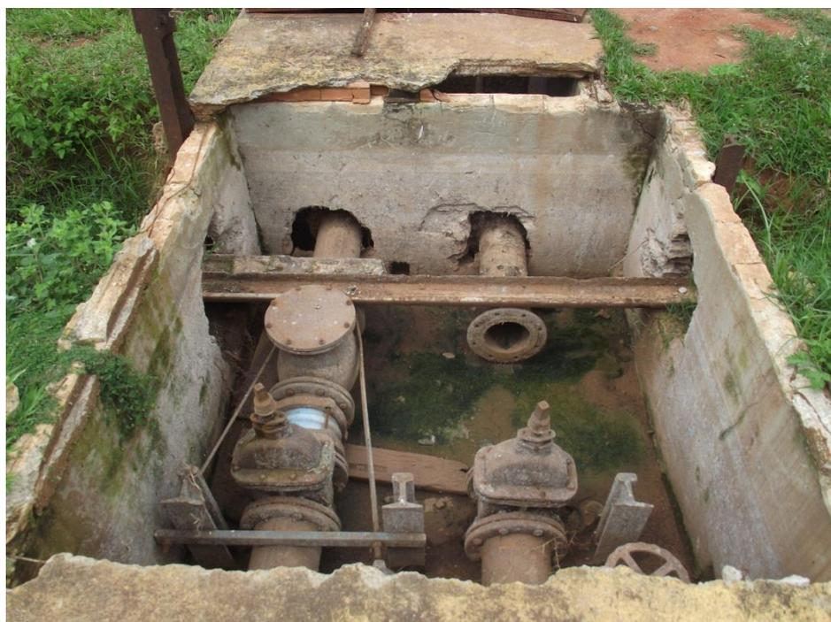
**Foto 182:** – Registros das Bombas de Recalque
