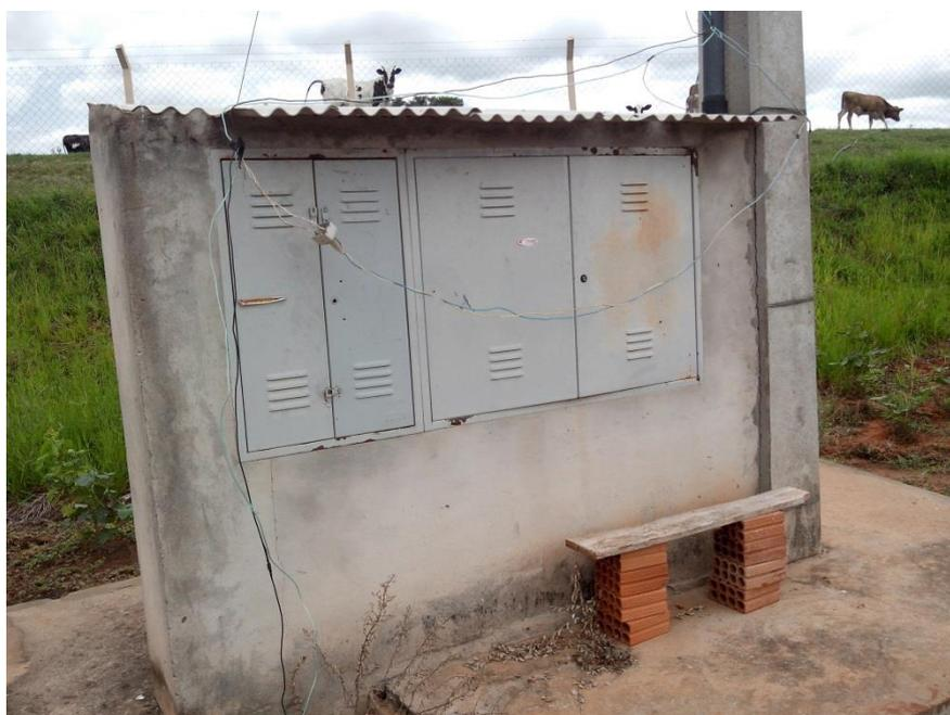
**Foto 176:** – Entrada de Energia do Quadro de Comando de Energia dos Motores das Bombas de Recalque
